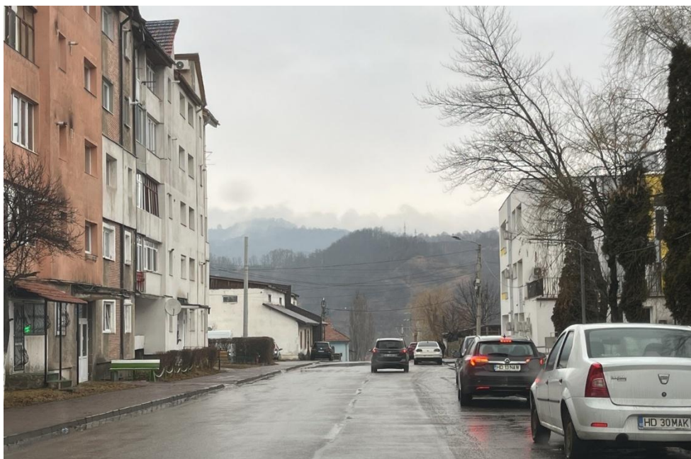
Figura nr. 10 - Prospect stradal - Strada Jiului 8
